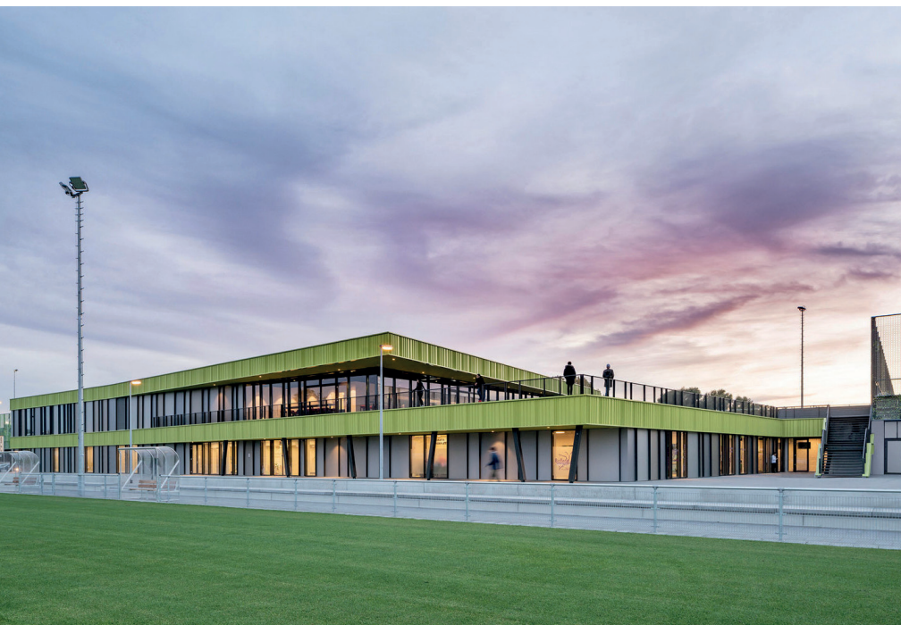
Moederscheim Moonen Architects, Complesso sportivo, Schiedam 2016. L'edificio principale ospita una sala sportiva, spazi per la danza e una caffetteria; sulla copertura, campi sportivi all'aperto
