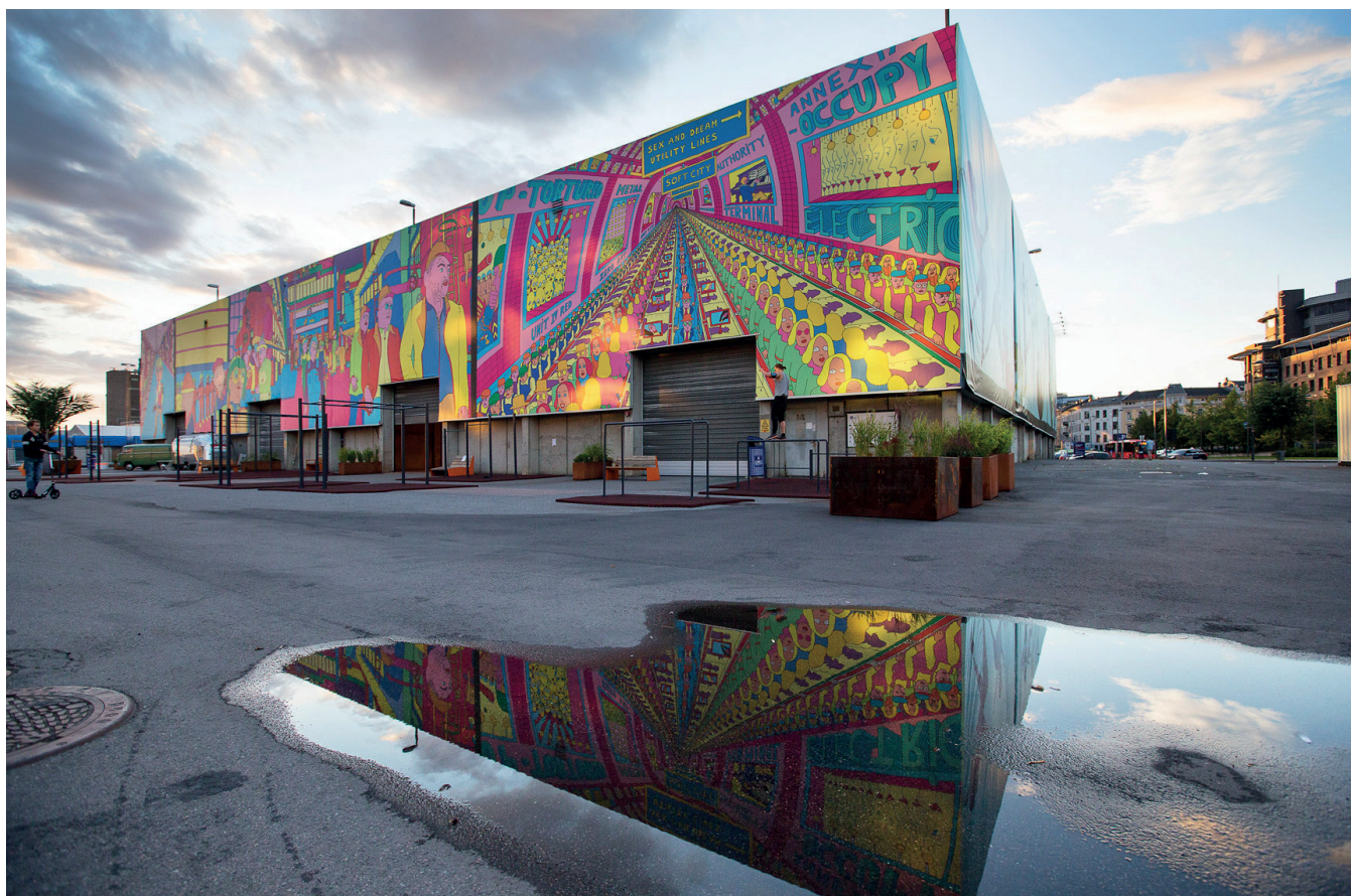
Riquilificazione del Capannone 13, Lungomare, Oslo 2016. L'edificio esistente, decorato dall'artista Pushwagner, accoglie una pista da skate e una palestra
