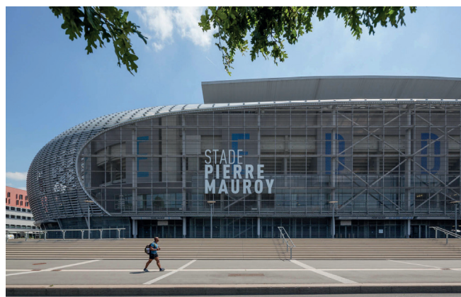
La facciata principale in rete metallica funge da supporto per la comunicazione
