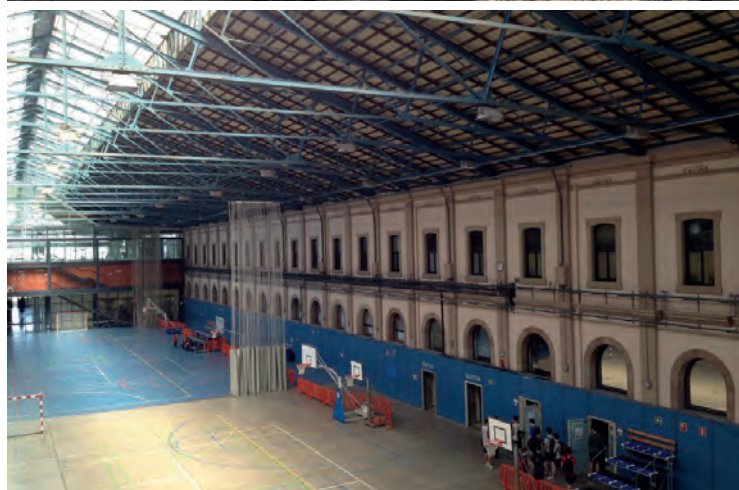
Sopra: immagine d'epoca della Stazione ferroviaria del Nord a Barcellona. Al centro: l'ampio spazio un tempo occupato dai binari durante le fasi di demolizione. Sotto: lo spazio sportivo polivalente ricavato dalla ristrutturazione della Stazione.
