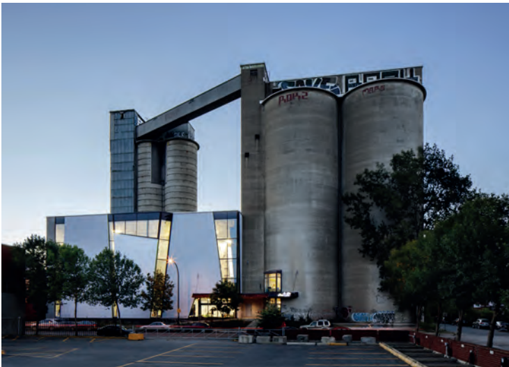
Smith Vigeant Architects, Palestra di arrampicata Allez-Up a Montréal: l'edificio sportivo riutilizza i silos di una raffineria di zucchero dismessa.
