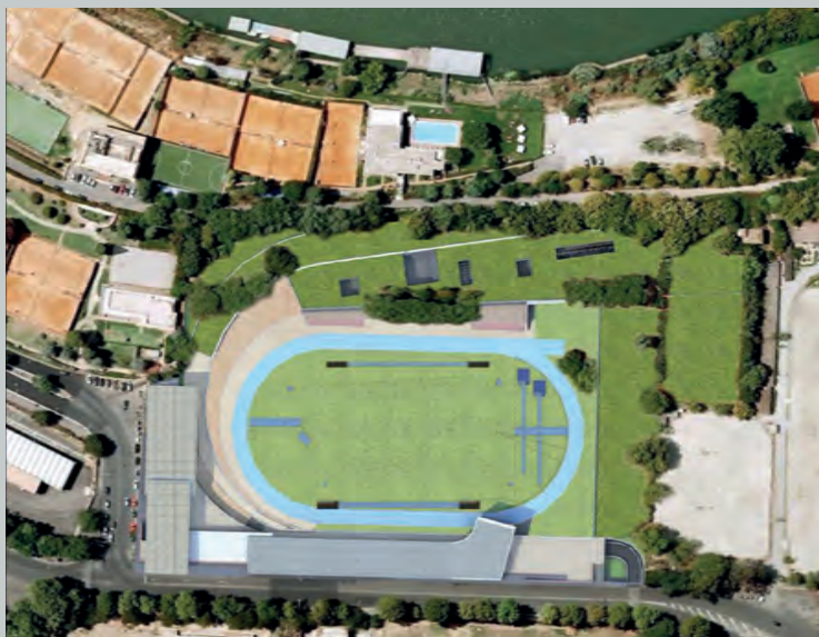
Stefano Gelagna, Progetto di ristrutturazione dello Stadio Paolo Rosi, Roma.
